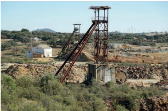
Fotografía 3. Castilletes de los pozos Guadiana y San Carlos, este último con el edificio de la máquina de extracción
