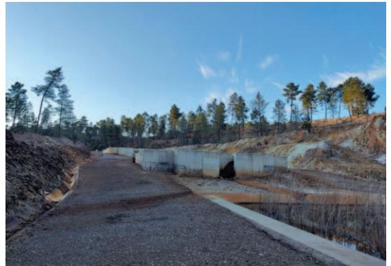
Fotografía 11. Tanque reactivo DAS-calizas y balsas decantadora con typha
