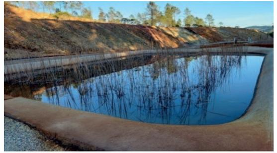
Fotografía 10. Balsa decantadora con typha<sup>2</sup>
