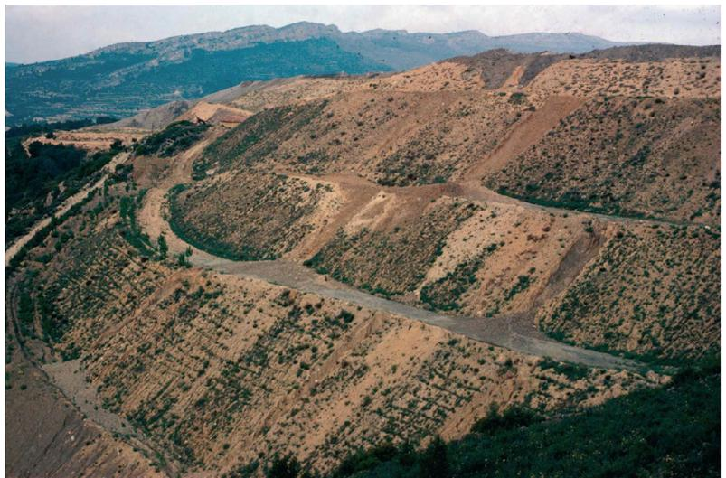
Figura 2. Topografía en talud-berma-cuneta. Mina Palestina, Castellote.
