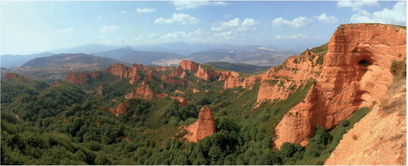
*Fig. 4. La peculiar topografía del sector principal de la mina de oro de Las Médulas es debida a la superposición a lo largo del tiempo de diversas operaciones de ruina montium o cortas de minado*
