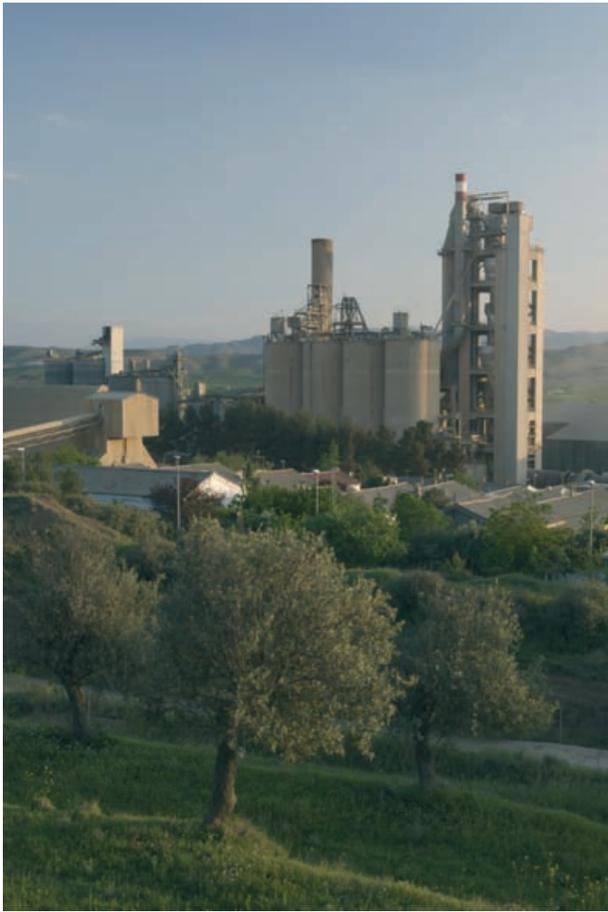
Horno KHD con enfriador de satélites, intercambiador de 5 etapas y precalcinador. Motor accionamiento de 550 Kw. y ventilador de 1.050 Kw. Producción 2.000 t/d.
